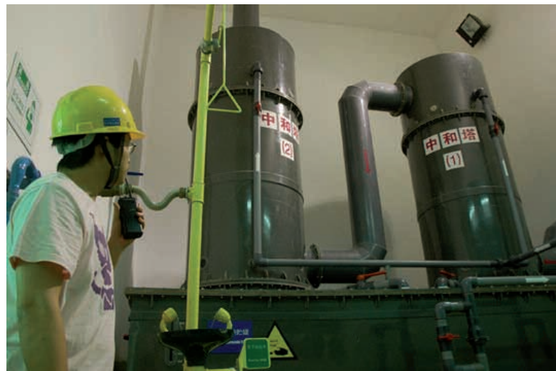
Abb. 18: Werk B des Chengdu Nr. 6 Wasserwerks
